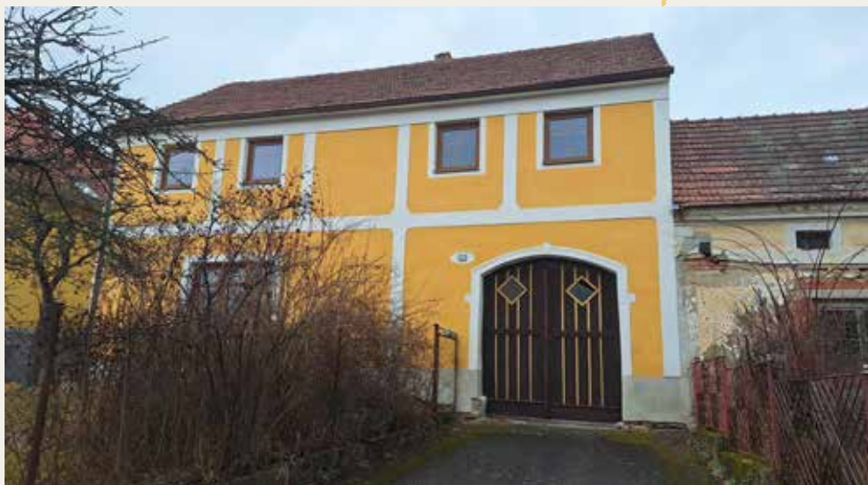
Budova bývalého hostince U Smrčků
