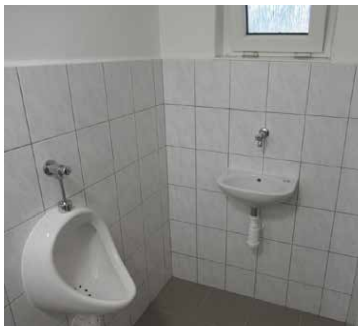
Rekonstrukce pánského WC
