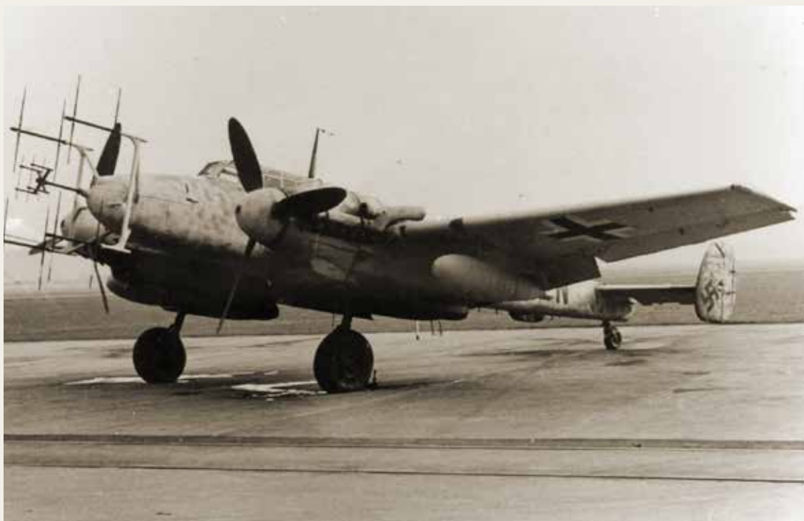
Nejslavnějším exemplářem výrobního bloku 740, ale patrně všech nočních stíhaček, se stal stroj WNr. 740 055, který pro poruchu motoru přistál v noci z 27. na 28. dubna 1944 na letišti v neutrálním Švýcarsku. Nesl nejnovější, utajovaný radar FuG 220 Lichtenstein SN-2b, starší FuG 202 Lichtenstein BC a prototyp „Schrägenmusik“ z dvou šikmo uložených 20 mm kanónů Rheinmettal-Borsig MG FF. Německá osádka byla jen krátce internována, ale nepoškozený stroj byl po měsíci špiónážních pokusů i diplomatických jednání úmyslně zničen explozí.
