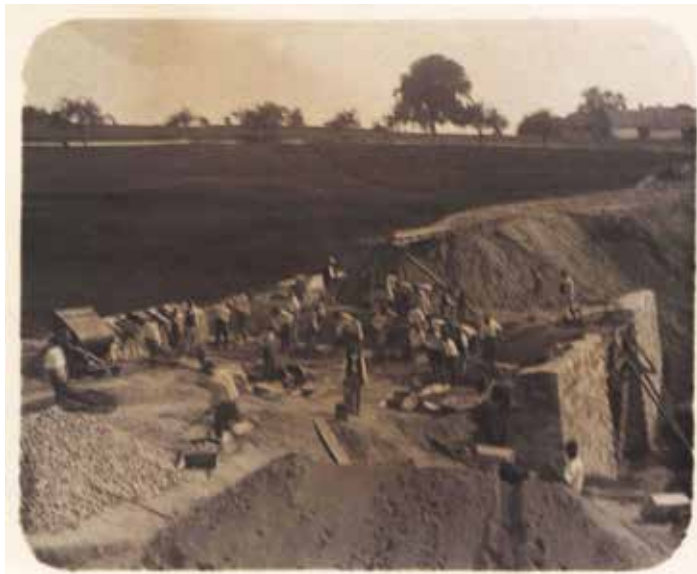
Stavba mostu na Červený vršek
