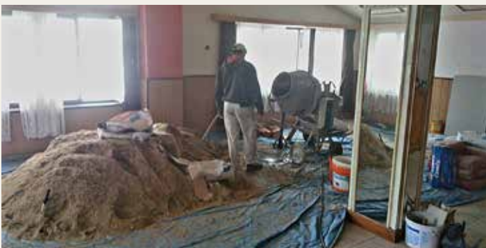
Stavební úpravy hostince (2015).
