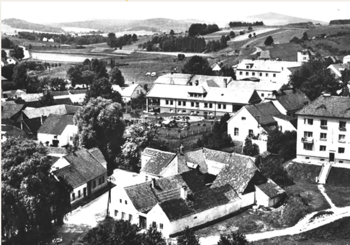
MŠ Čtyřlístek po dostavbě. Vlevo řada domů, v níž stál i hostinec U Kabrhelů.
