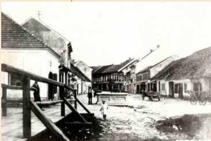
Nedrtál na archívním snímku
