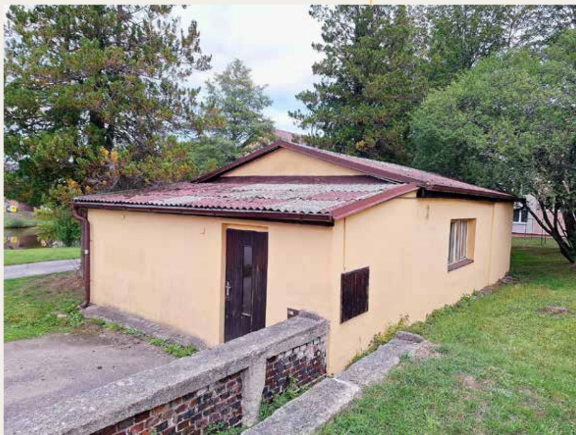
Budova bývalého hostince (2026).
