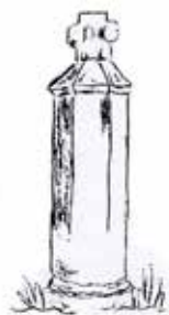
❶ Kamenná Boží muka u mostu v Jeronýmově ulici.
