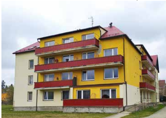
DPS opravené balkony a fasáda
