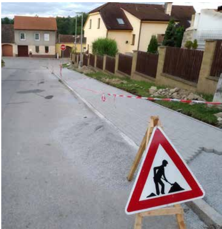
Chodník Nové město/Budovatelská
