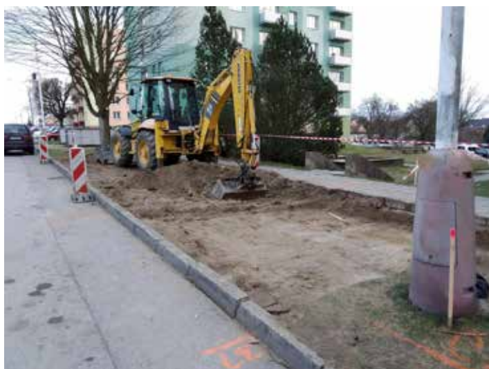
Parkovací stání na sídlišti Budovatelská
