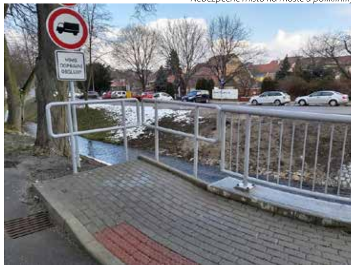
Opravené místo na mostě u polikliniky
