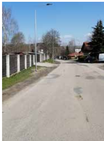
Veřejné osvětlení u rekonstruovaného mostu ve směru na Borovany
