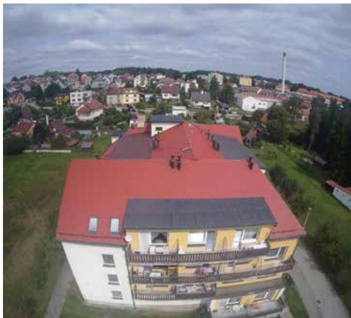
DPS opravená střecha
