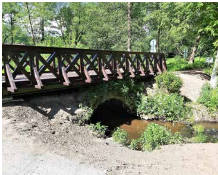
Očištění původního mostu proběhne v rámci jeho plánové opravy.
