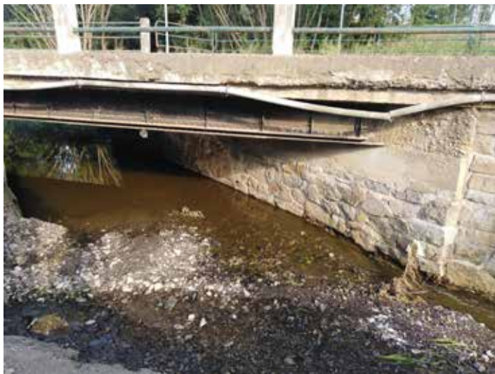
Nosníky původního mostu přes Farský potok (2020).
